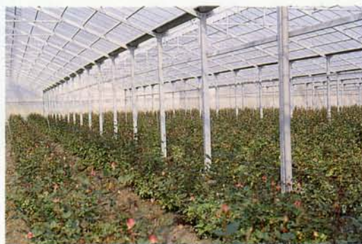
圖三：鋼骨結構及硬質塑膠板的防雨設施
