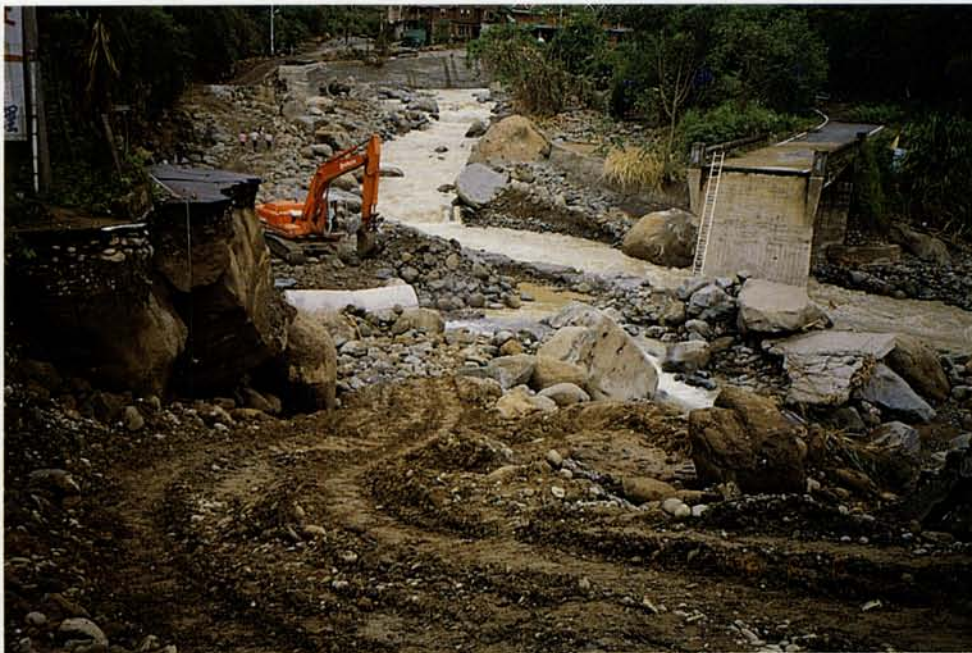
相片5. 土石流衝斷橋樑。
