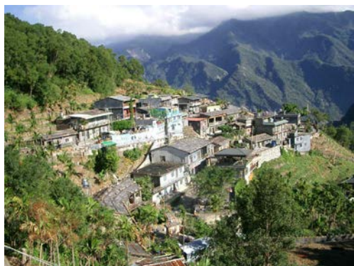
霧台村一隅（上霧台部落）
