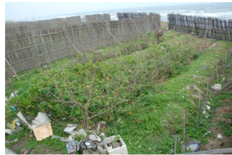
圖 12 攔砂籬搭配定砂植物 Figure 12 Wind break with sand plants.
