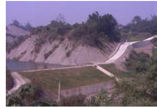
SBE: 129.3 (No. 19) 土堤植生
