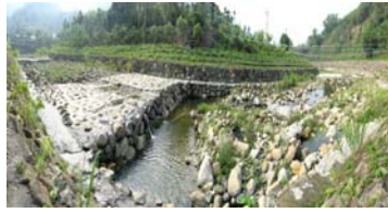
SBE: 158.23 (No. 10) 砌石溝
